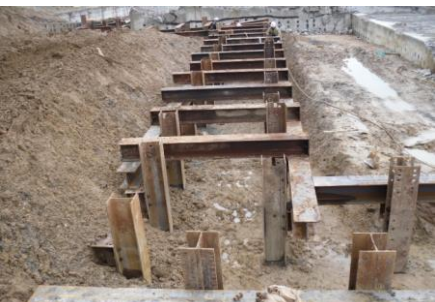
수평 연결재 설치
