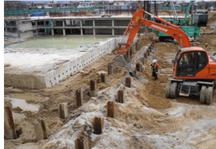
전.후열 말뚝 설치
