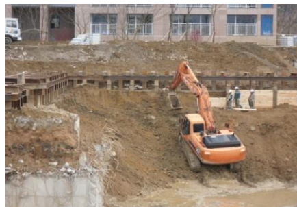
굴착 및 토류판 설치
